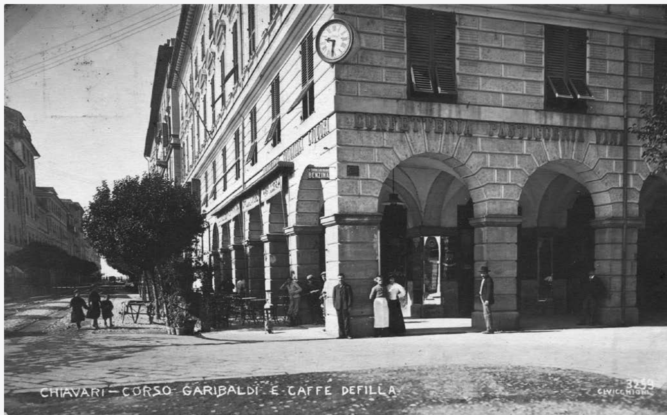
Corso Garibaldi, 1908, the arcaded corner of the Caffè Defilla
